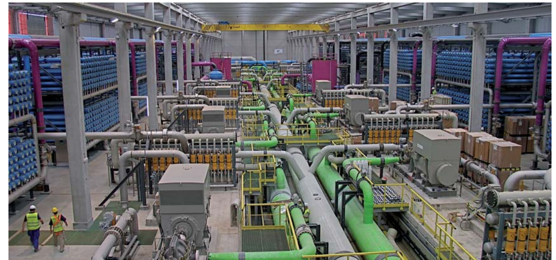
Edificio de ósmosis.
