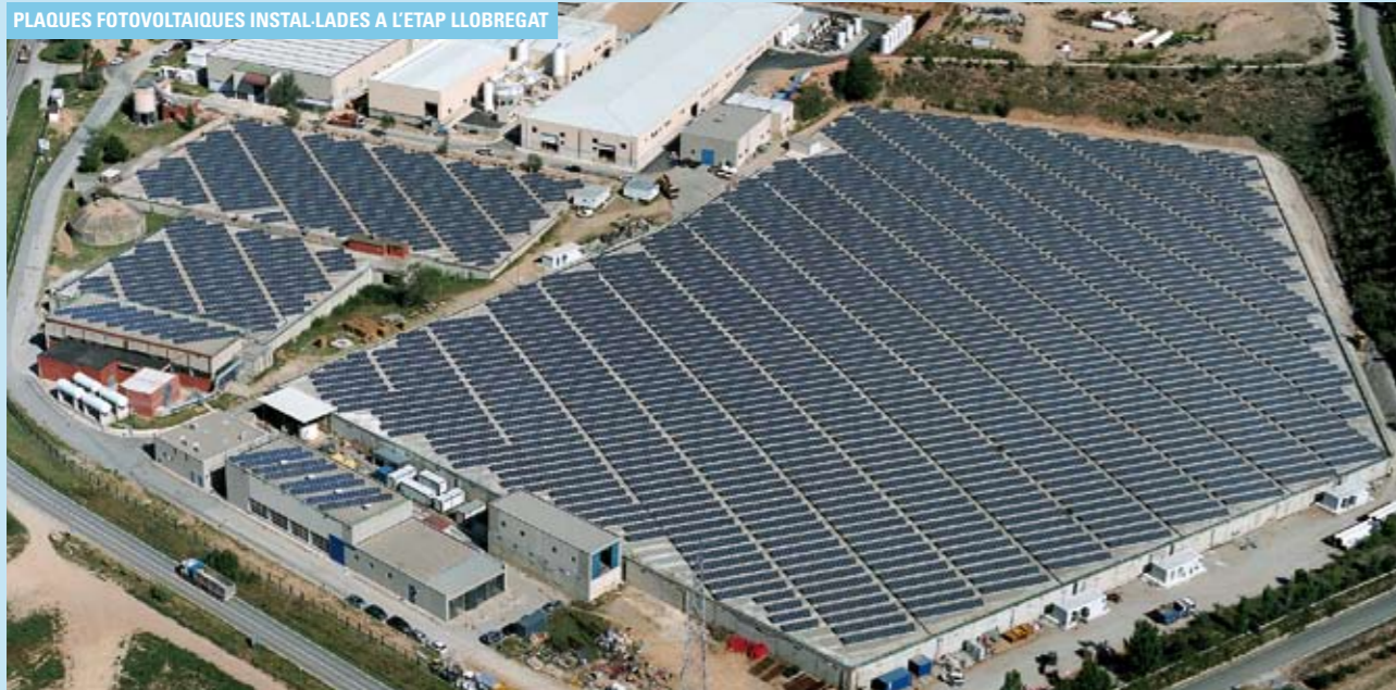
PLAQUES FOTOVOLTAIQUES INSTAL·LADES A L'ETAP LLOBREGAT
